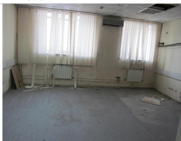
Фотография 6. Неэксплуатируемые помещения
