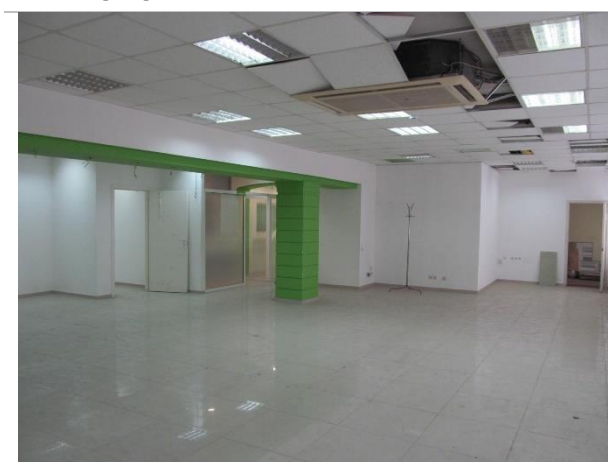
Фотография 5. Неэксплуатируемые помещения
