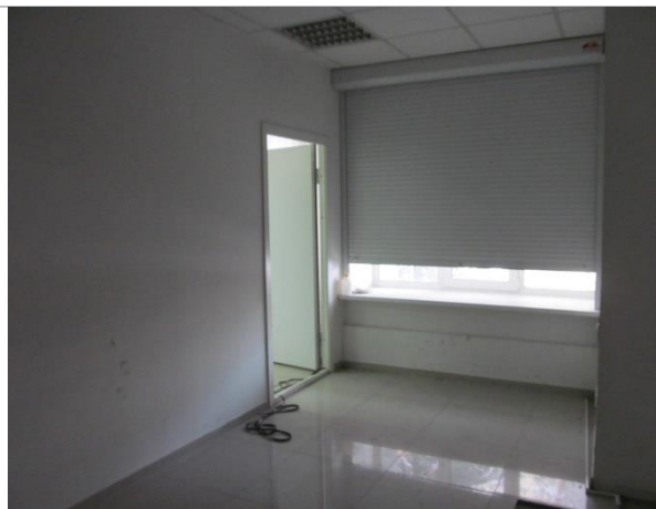
Фотография 9. Неэксплуатируемые помещения.
