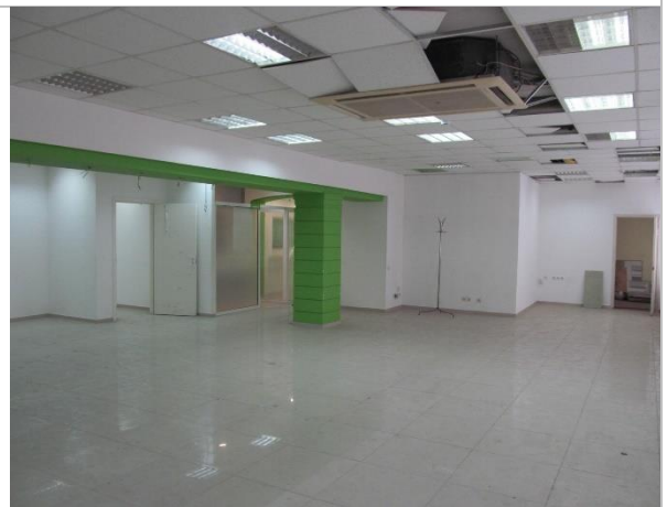
Фотография 10. Неэксплуатируемые помещения.
