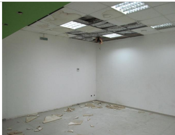
Фотография 11. Неэксплуатируемые помещения.
