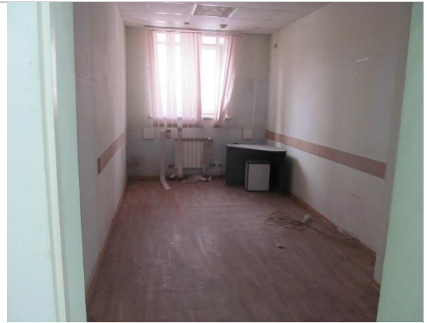
Фотография 20. Неэксплуатируемые помещения.
